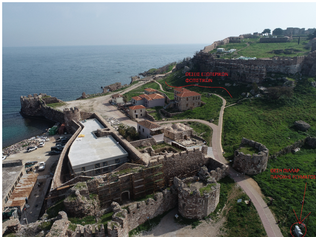
Εικόνα 1: Αεροφωτογραφία Κάτω Κάστρου Μυτιλήνης, με τη θέση των φωτιστικών εξωτερικά των τειχών και την θέση του Pillar από όπου θα ηλεκτροδοτηθούν τα φωτιστικά
